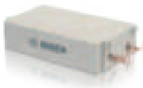
Las nuevas unidades SBOX incluyen 6 modelos diferentes, integrando de 1 a 12 puertos de conexión. Una de las nuevas unidades SBOX, incluye una función especial de detección de fuga de refrigerante. Dimensiones y pesos reducidos en comparación con los modelos anteriores.
